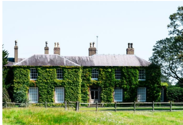
Abbildung 44 Bodengebundene Fassadenbegrünung (Photo by Ethan Kent on Unsplash)
