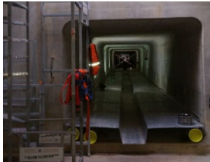
图28：内卡公园的排污明渠热交换器
