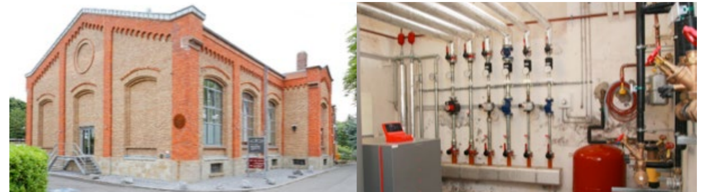
图18：哈恩（Haan）的老旧泵站 — 一栋再利用的非住宅建筑内配有冰蓄冷设备的热泵
