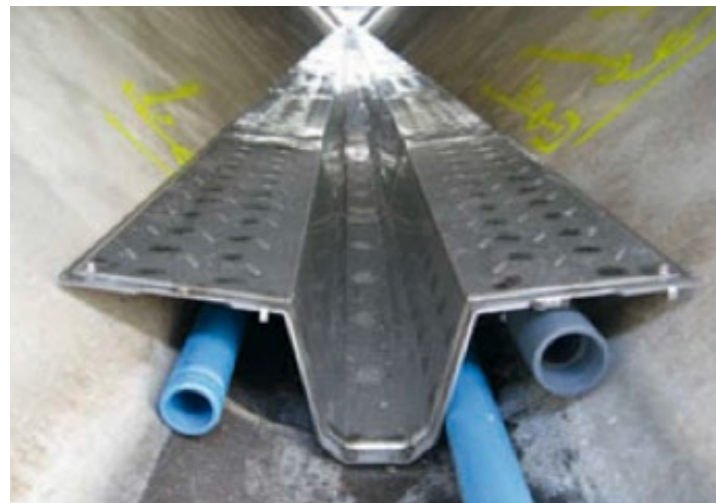
图28：内卡公园的排污明渠热交换器
