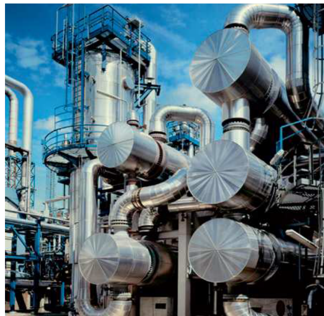
图52: 卡尔斯鲁厄工业用地上的热交换器
