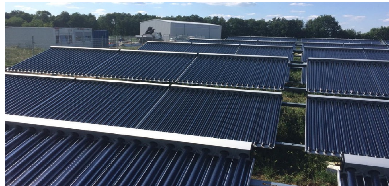
图42：森夫滕贝格附近集热站的真空管集热器
