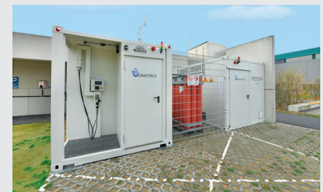
Bild 4 Demonstrationsanlage im Technologiepark Berlin-Adlershof: Die Fa. Graforce stellt hier in einem selbst entwickelten Plasmalyse-Verfahren Wasserstoff her. Dabei wird Schmutzwasser, das beispielsweise bei Produktionsprozessen in Biogas-, Klär- oder Industrieanlagen anfällt, mit Hilfe von elektrischem Strom in Sauerstoff und Wasserstoff gespalten – ähnlich der Elektrolyse. Quelle: Graforce
